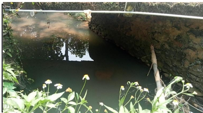
KONDISI BANGUNAN BAWAH
