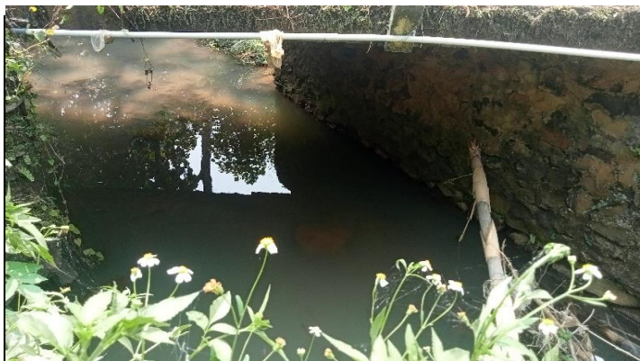
KONDISI BANGUNAN BAWAH
