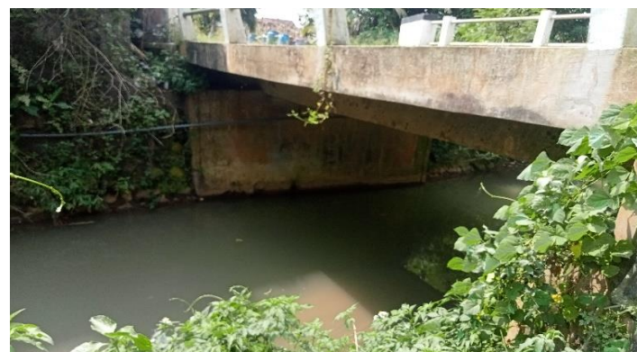
KONDISI BANGUNAN BAWAH
