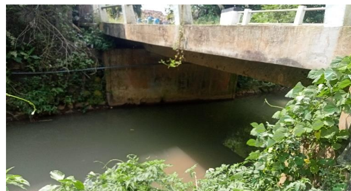
KONDISI BANGUNAN BAWAH
