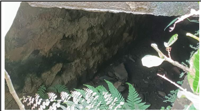
KONDISI BANGUNAN BAWAH
