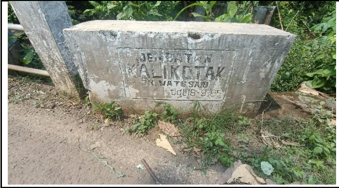
PAPAN NAMA JEMBATAN
