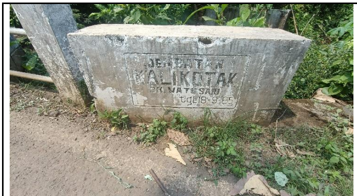
PAPAN NAMA JEMBATAN
