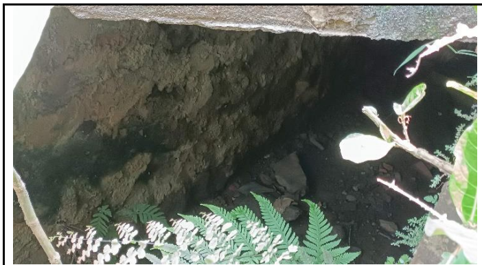
KONDISI BANGUNAN BAWAH
