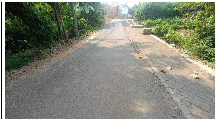
KONDISI JALAN PENDEKAT
