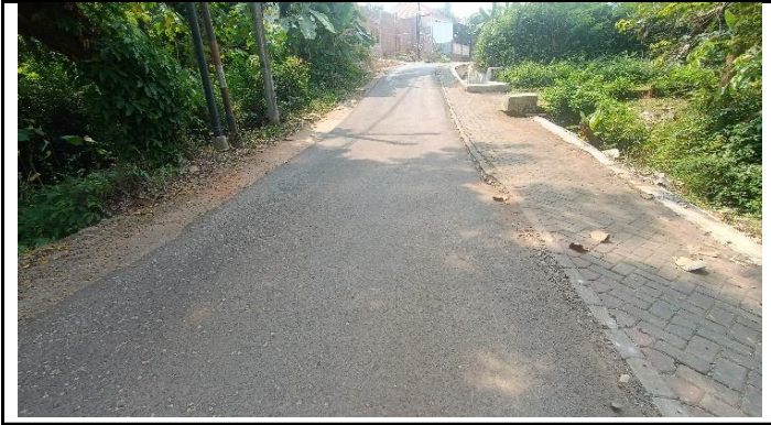
KONDISI JALAN PENDEKAT
