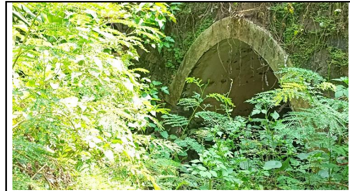
KONDISI PELENGKUNG JEMBATAN
