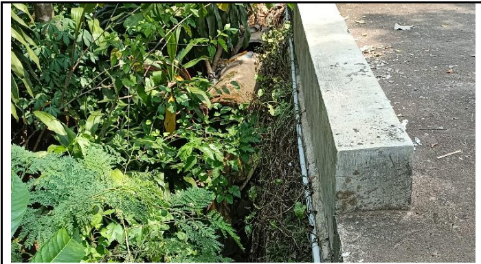
KONDISI SANDARAN JEMBATAN
