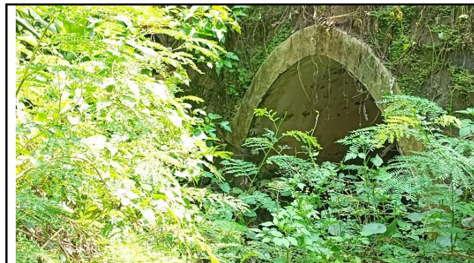
KONDISI PELENGKUNG JEMBATAN
