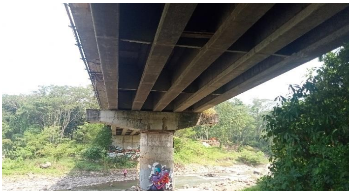
KONDISI BANGUNAN BAWAH
