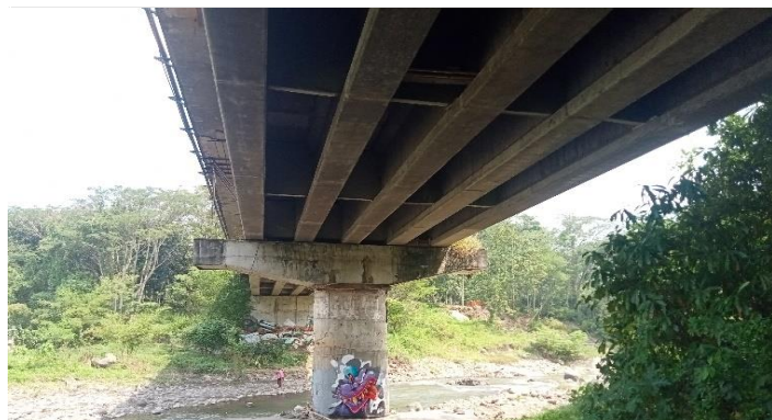
KONDISI BANGUNAN BAWAH
