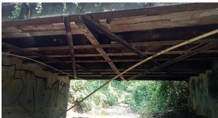
KONDISI BANGUNAN BAWAH
