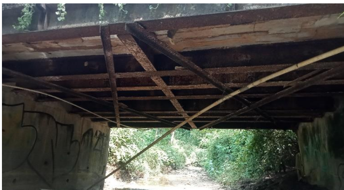
KONDISI BANGUNAN BAWAH
