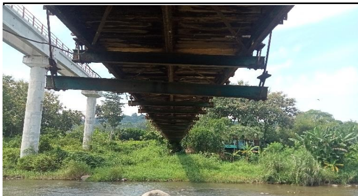
KONDISI BANGUNAN BAWAH
