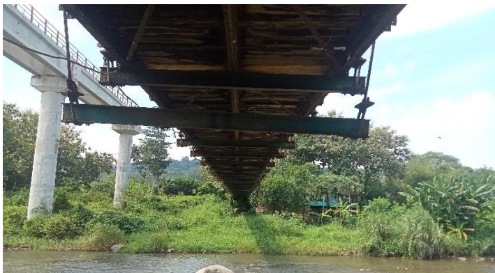
KONDISI BANGUNAN BAWAH
