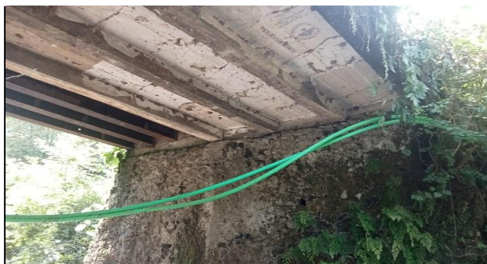
KONDISI BANGUNAN BAWAH
