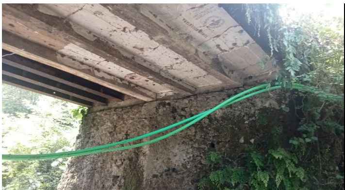
KONDISI BANGUNAN BAWAH
