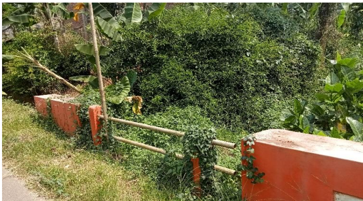
KONDISI SANDARAN RAILING
