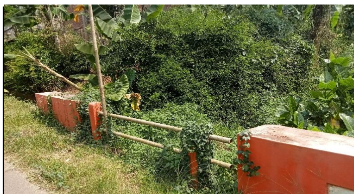
KONDISI SANDARAN RAILING
