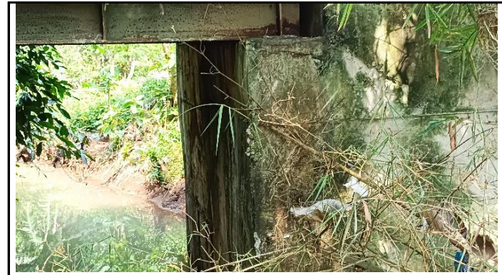
KONDISI KEPALA JEMBATAN
