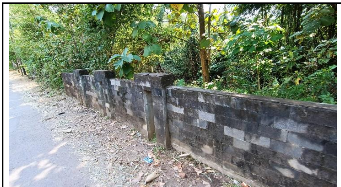
KONDISI SANDARAN JEMBATAN
