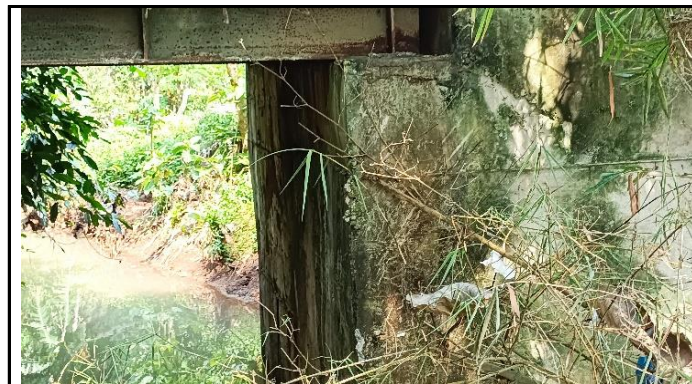
KONDISI KEPALA JEMBATAN
