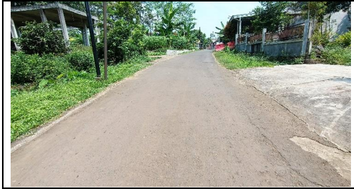
KONDISI JALAN PENDEKAT
