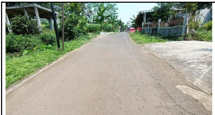
KONDISI JALAN PENDEKAT
