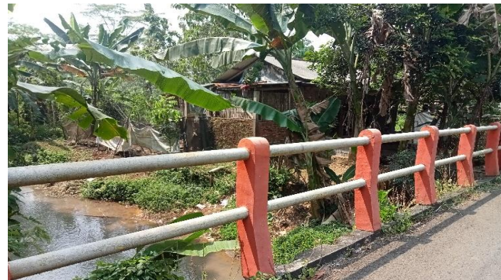
KONDISI SANDARAN RAILING
