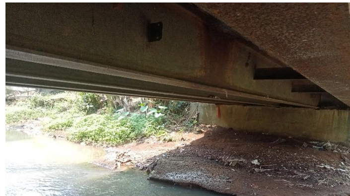
KONDISI BANGUNAN BAWAH
