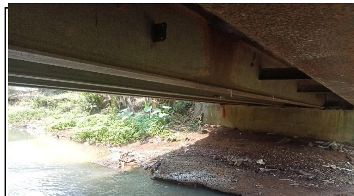
KONDISI BANGUNAN BAWAH
