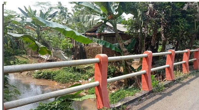
KONDISI SANDARAN RAILING
