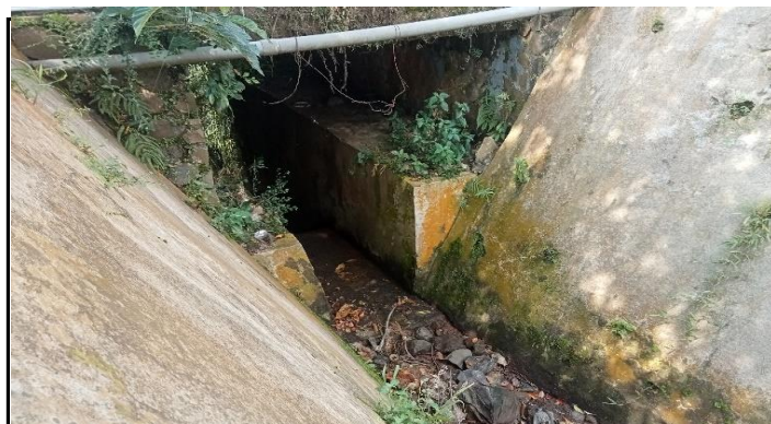
KONDISI BANGUNAN BAWAH
