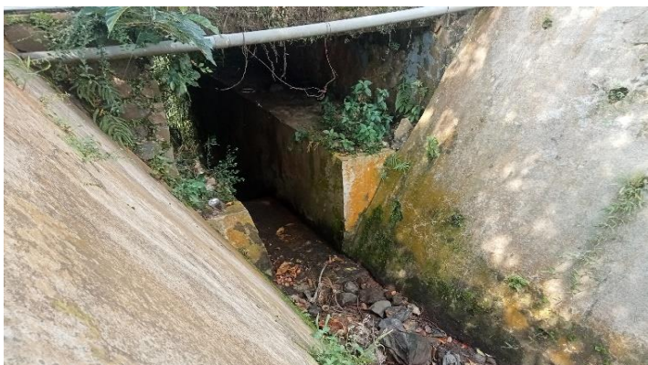
KONDISI BANGUNAN BAWAH
