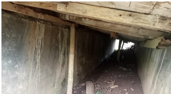
KONDISI BANGUNAN BAWAH
