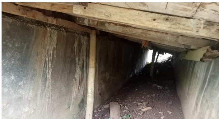
KONDISI BANGUNAN BAWAH
