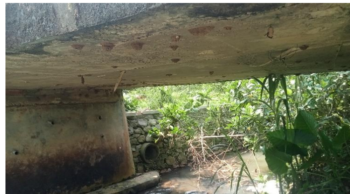
KONDISI BANGUNAN BAWAH
