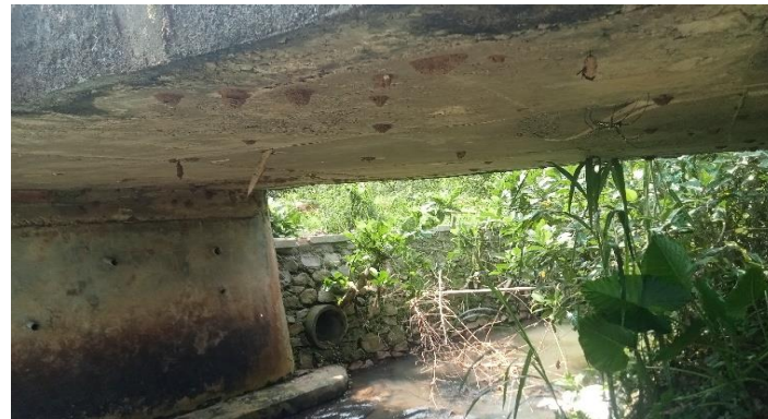
KONDISI BANGUNAN BAWAH
