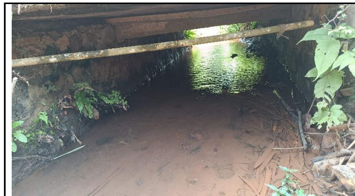
KONDISI BANGUNAN BAWAH
