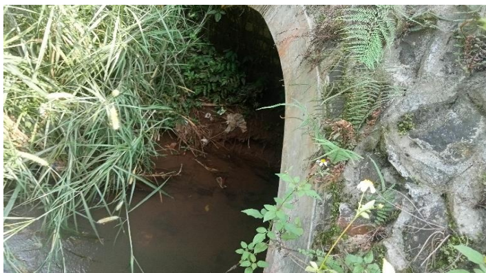
KONDISI BANGUNAN BAWAH
