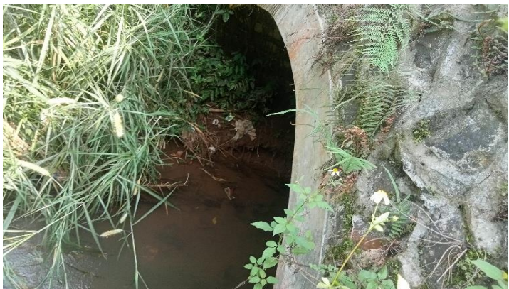
KONDISI BANGUNAN BAWAH
