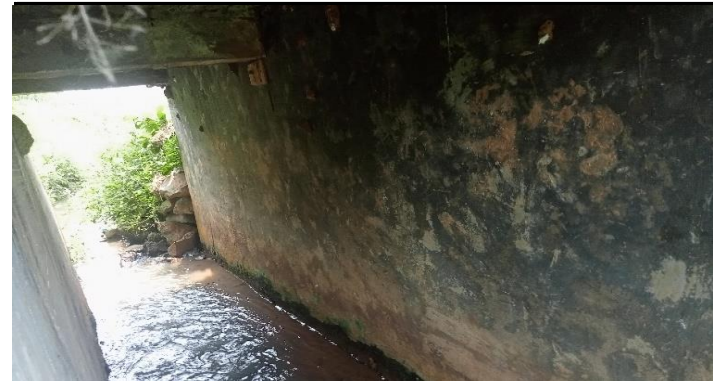
KONDISI BANGUNAN BAWAH
