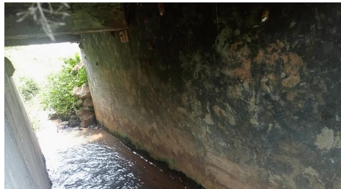
KONDISI BANGUNAN BAWAH
