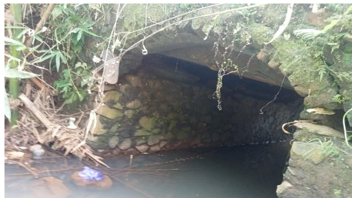
KONDISI BANGUNAN BAWAH
