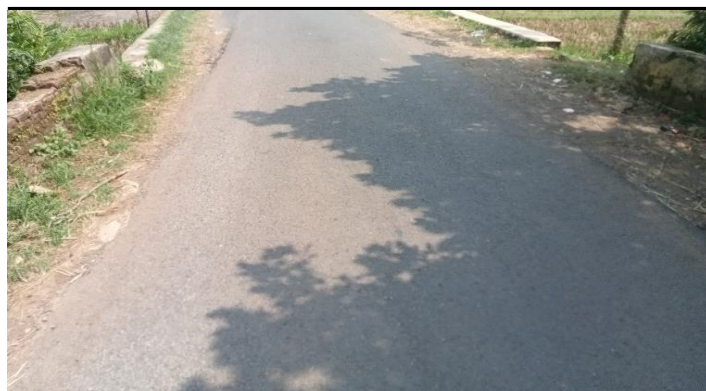
KONDISI LAPISAN PERMUKAAN LANTAI
