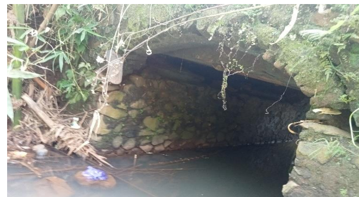
KONDISI BANGUNAN BAWAH
