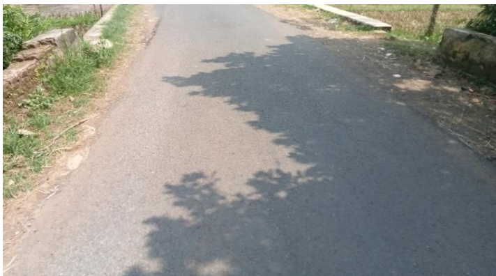
KONDISI LAPISAN PERMUKAAN LANTAI
