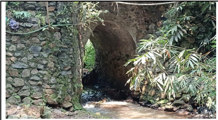
KONDISI BANGUNAN BAWAH
