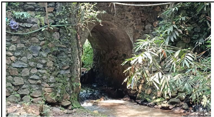
KONDISI BANGUNAN BAWAH
