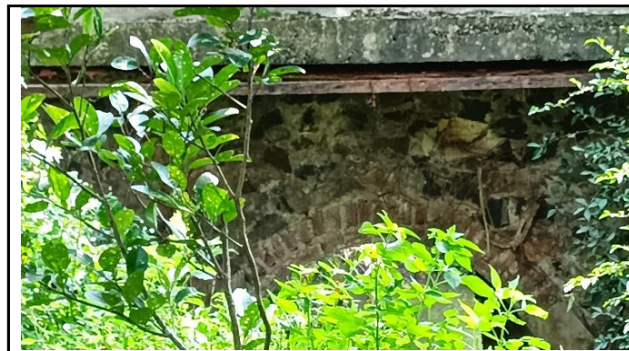
KONDISI PELENGKUNG JEMBATAN
