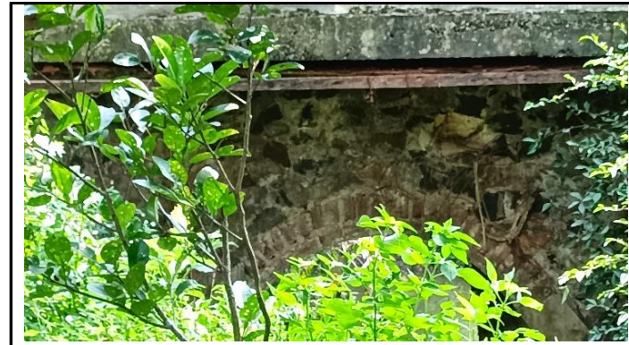
KONDISI PELENGKUNG JEMBATAN
