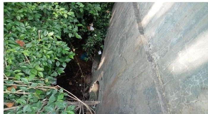
KONDISI BANGUNAN BAWAH
