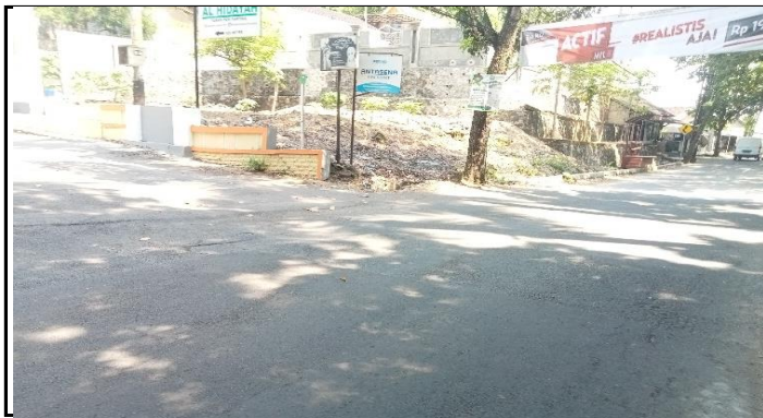
KONDISI LAPIASN PERMUKAAN LANTAI
