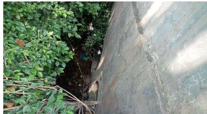
KONDISI BANGUNAN BAWAH
