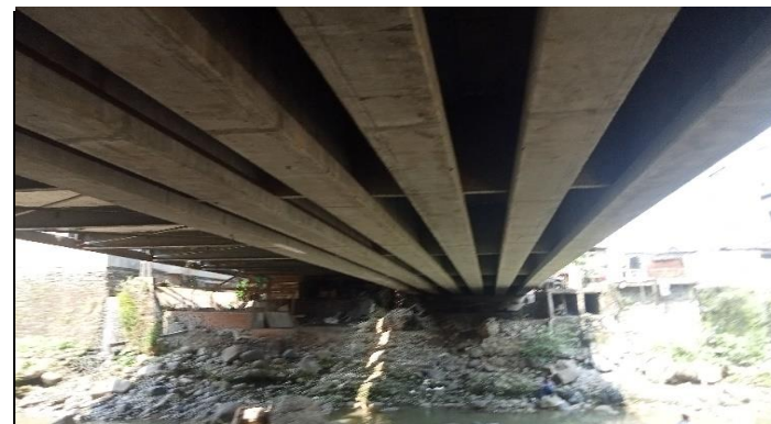
KONDISI BANGUNAN BAWAH
