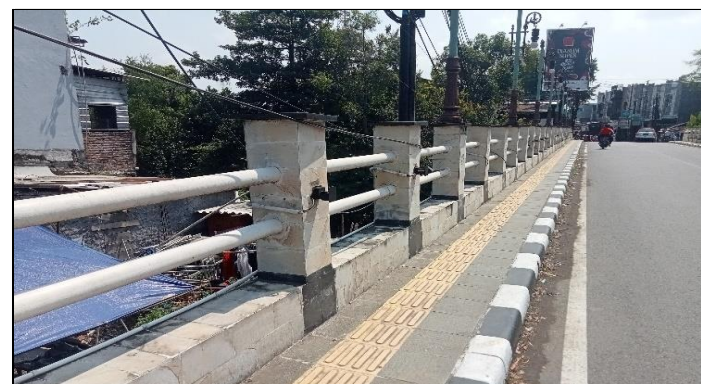
KONDISI SANDARAN DAN TROTOAR
