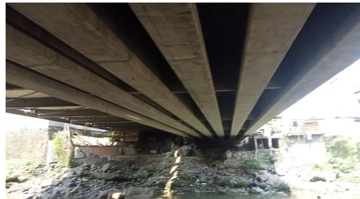
KONDISI BANGUNAN BAWAH
