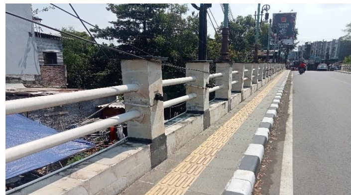
KONDISI SANDARAN DAN TROTOAR
