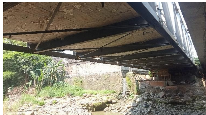
KONDISI BANGUNAN BAWAH
