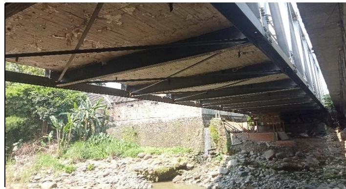
KONDISI BANGUNAN BAWAH
