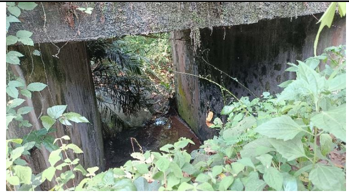
KONDISI BANGUNAN BAWAH
