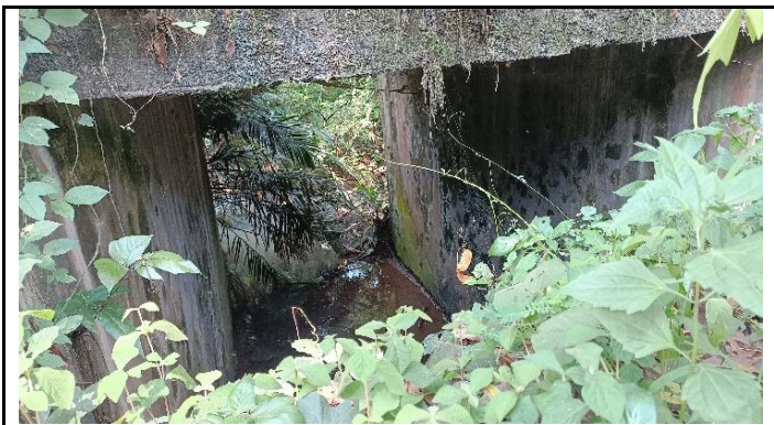
KONDISI BANGUNAN BAWAH
