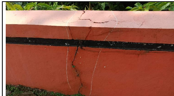
PARAPET RETAK
