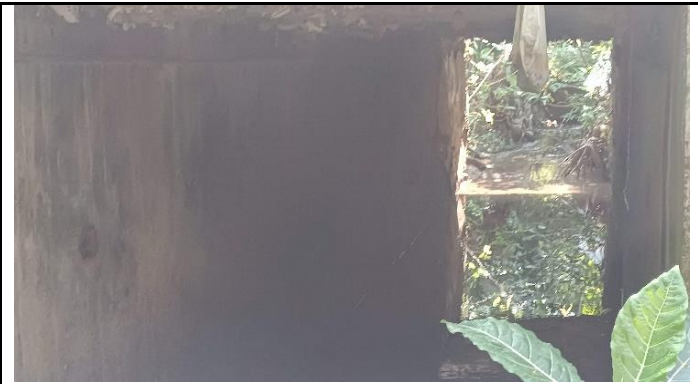
KONDISI BANGUNAN BAWAH
