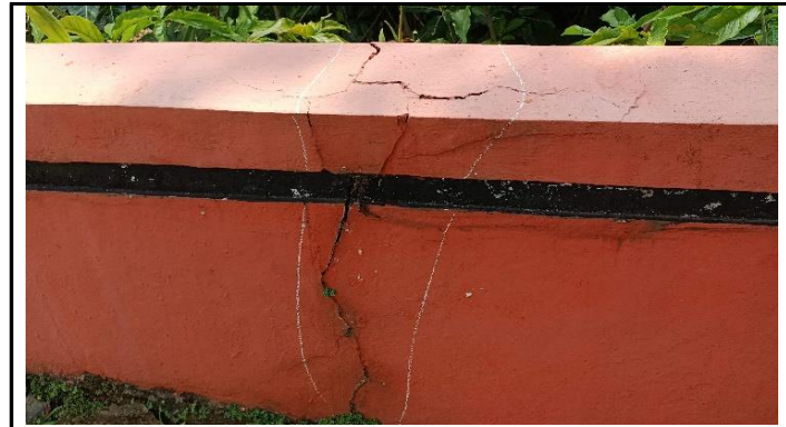
PARAPET RETAK
