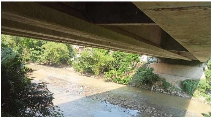
KONDISI BANGUNAN BAWAH
