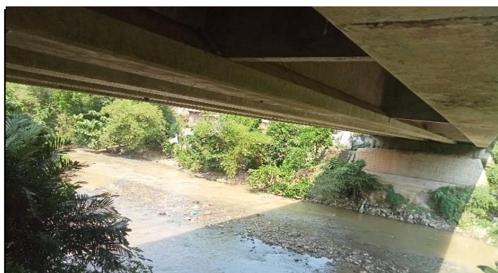
KONDISI BANGUNAN BAWAH
