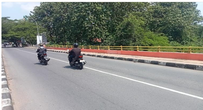
KONDISI LAPISAN PERMUKAAN LANTAI
