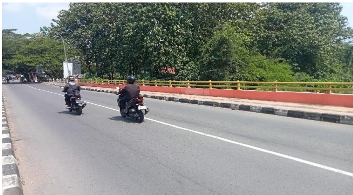
KONDISI LAPISAN PERMUKAAN LANTAI
