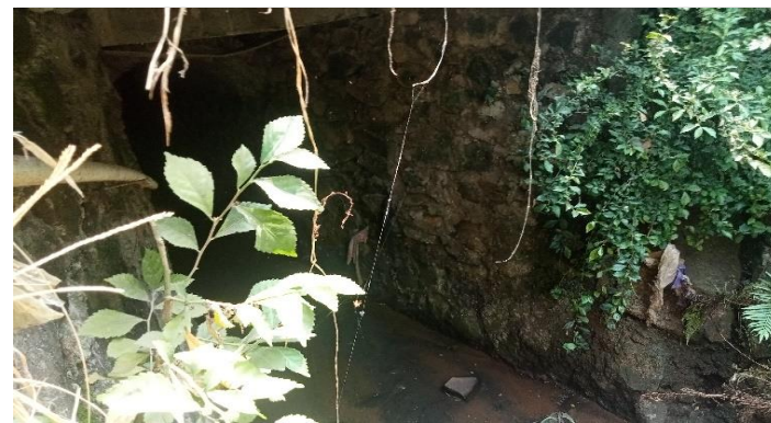
KONDISI BANGUNAN BAWAH
