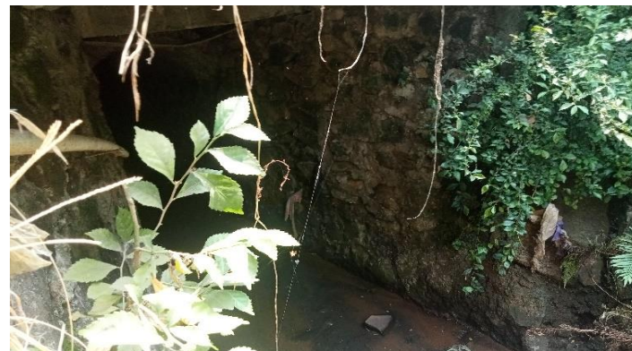
KONDISI BANGUNAN BAWAH
