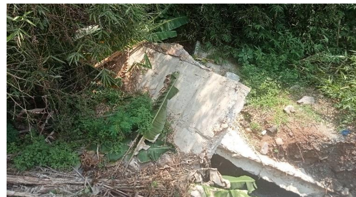
DINDING PENAHAN LONGSONG DI ALIRAN SUNGAI
