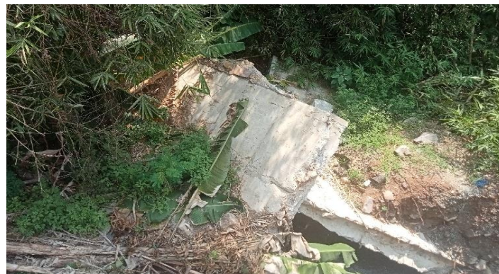
DINDING PENAHAN LONGSONG DI ALIRAN SUNGAI
