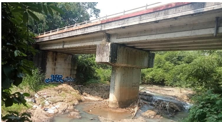
KONDISI BANGUNAN BAWAH
