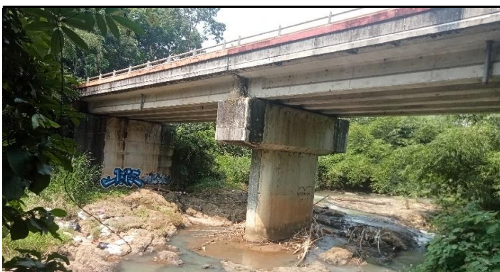
KONDISI BANGUNAN BAWAH
