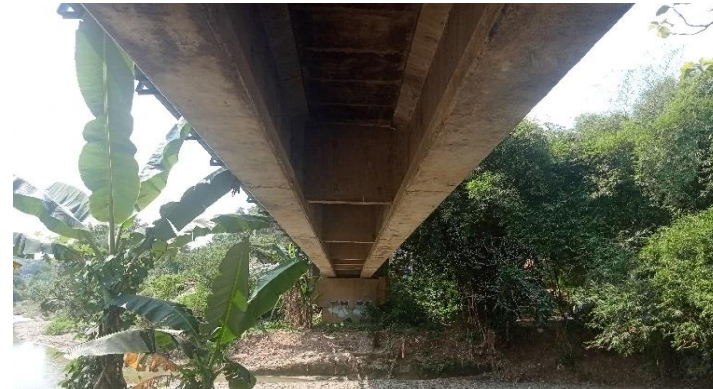
KONDIDI BANGUNAN BAWAH
