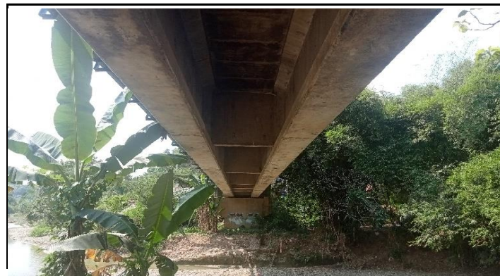
KONDIDI BANGUNAN BAWAH
