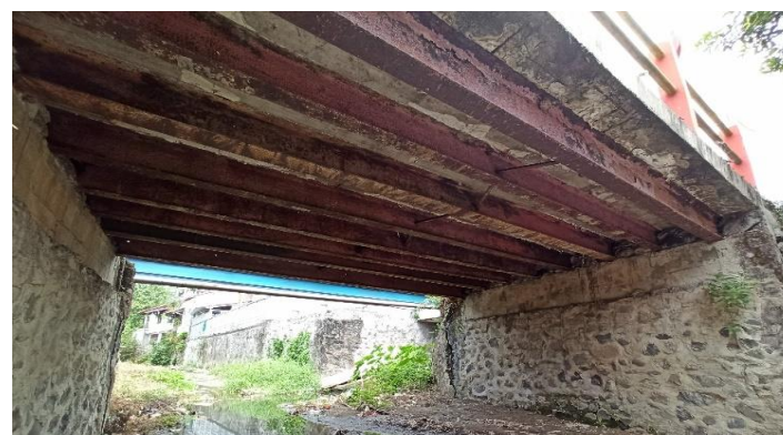
KONDISI BANGUNAN BAWAH
