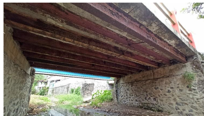
KONDISI BANGUNAN BAWAH
