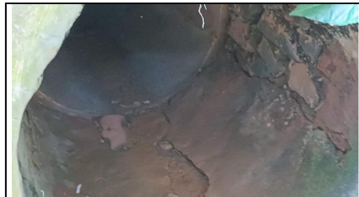
KONDISI BANGUNAN BAWAH
