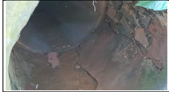
KONDISI BANGUNAN BAWAH
