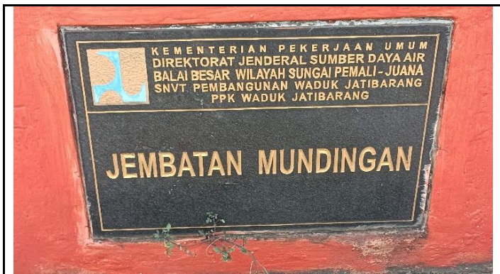
PAPAN NAMA JEMBATAN
