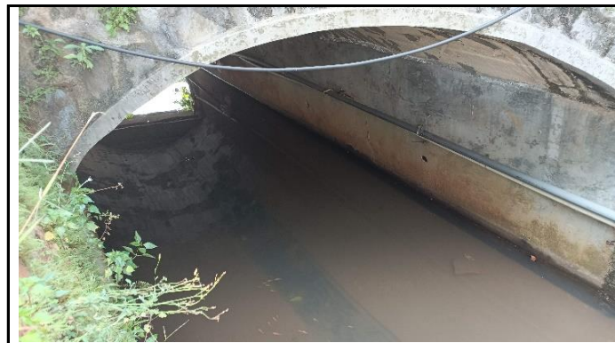
KONDISI BANGUNAN BAWAH
