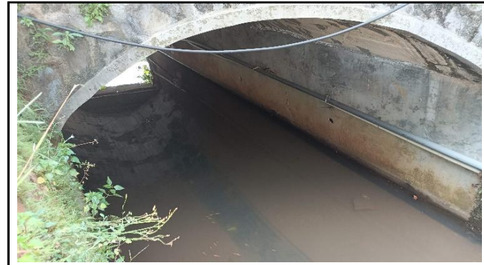
KONDISI BANGUNAN BAWAH
