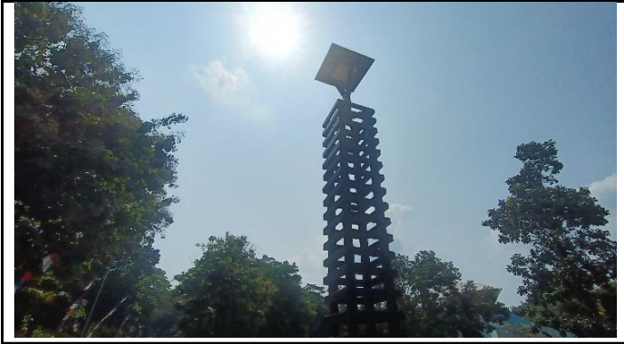
KONDISI LAMPU PENERANGAN JEMBATAN
