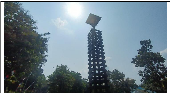
KONDISI LAMPU PENERANGAN JEMBATAN
