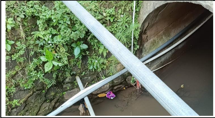
KONDISI PIPA UTILITAS AIR MINUM
