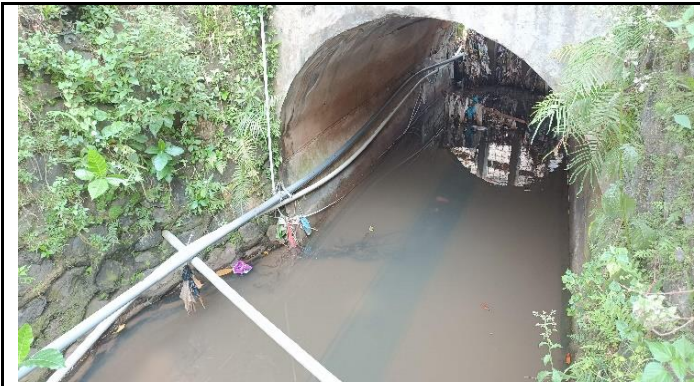
KONDISI BANGUNAN BAWAH
