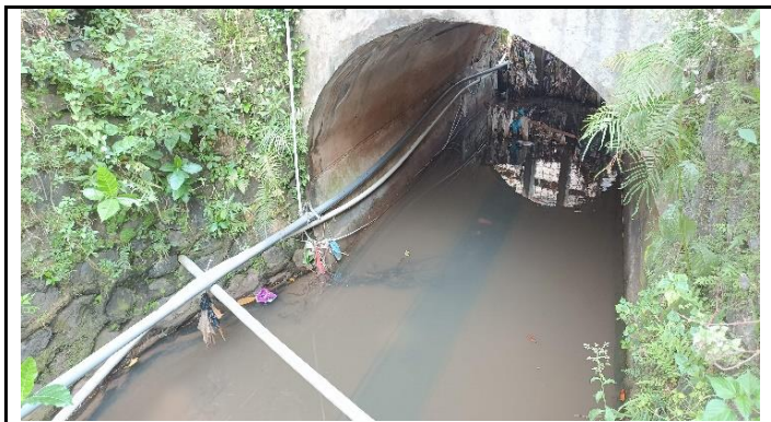
KONDISI BANGUNAN BAWAH
