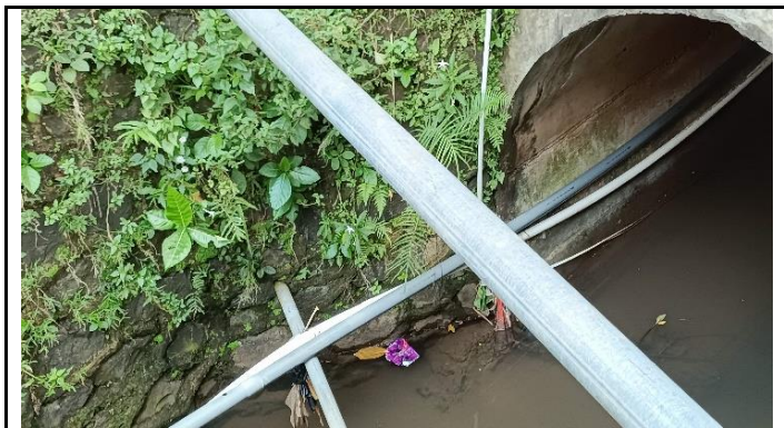
KONDISI PIPA UTILITAS AIR MINUM
