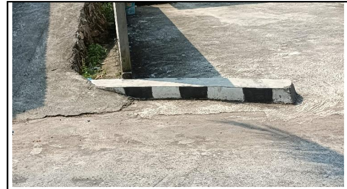
SANDARAN JEMBATAN TERLALU RENDAH
