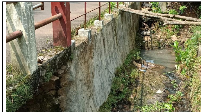
STRUKTUR PENAHAN TANAH JALAN PENDEKAT
