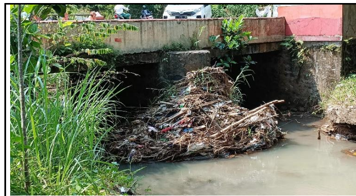
PENUMPUKAN DEBRIS SAMPAH PADA ALIRAN SUNGAI
