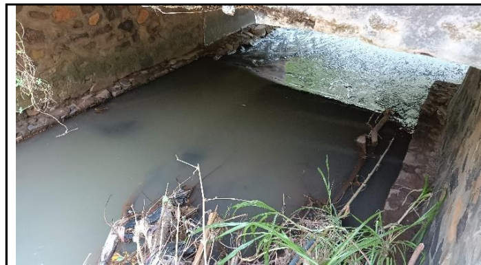
KONDISI BANGUNAN BAWAH
