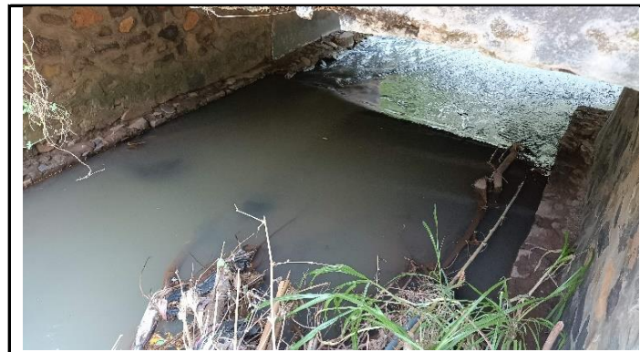
KONDISI BANGUNAN BAWAH
