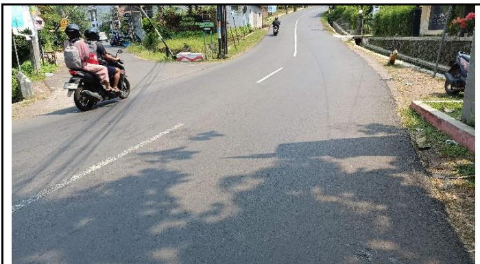
KONDISI JALAN PENDEKAT
