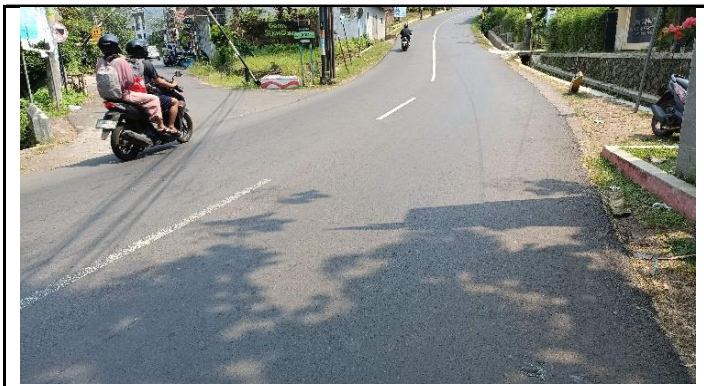
KONDISI JALAN PENDEKAT
