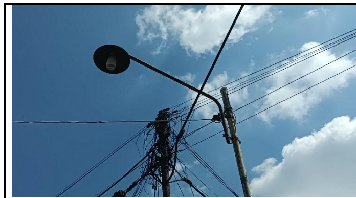
KONDISI LAMPU PENERANGAN JEMBATAN
