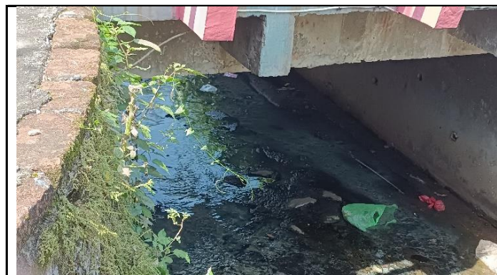
KONDISI BANGUNAN BAWAH
