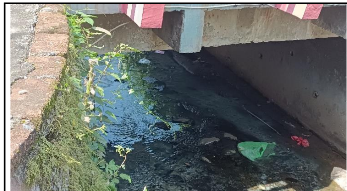
KONDISI BANGUNAN BAWAH
