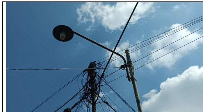
KONDISI LAMPU PENERANGAN JEMBATAN
