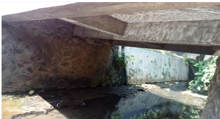
KONDISI BANGUNAN BAWAH
