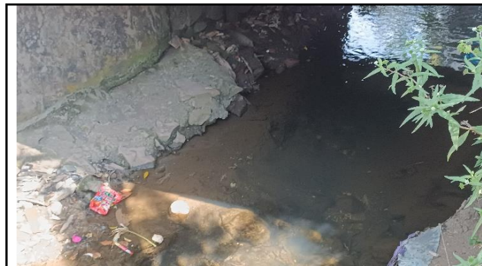
KONDISI BANGUNAN BAWAH
