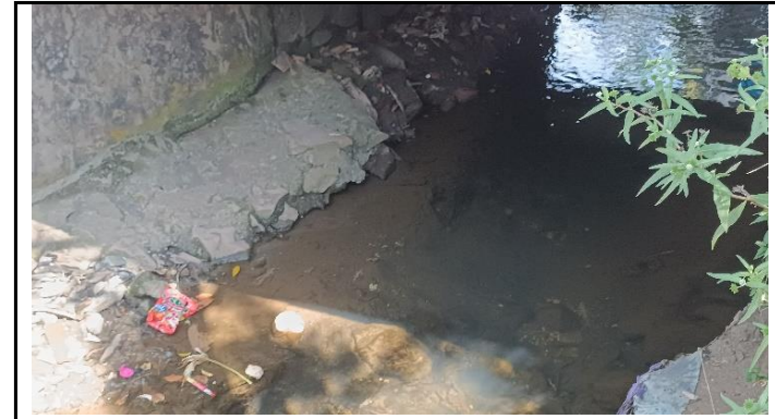
KONDISI BANGUNAN BAWAH
