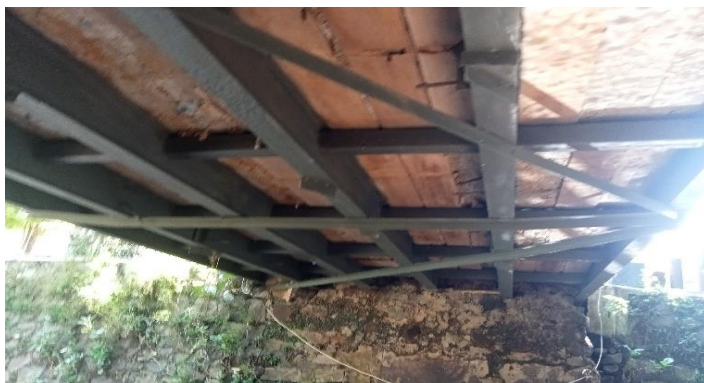
KONDISI BANGUNAN BAWAH
