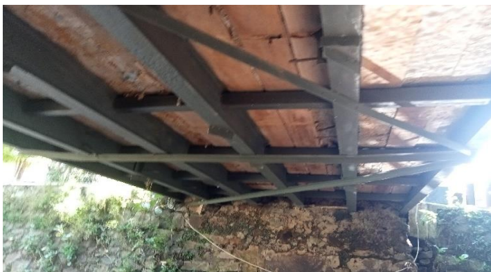
KONDISI BANGUNAN BAWAH
