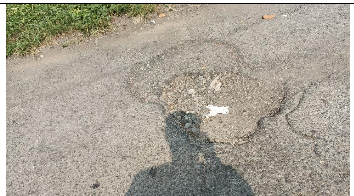
LAPISAN PERMUKAAN LANTAI BERLUBANG
