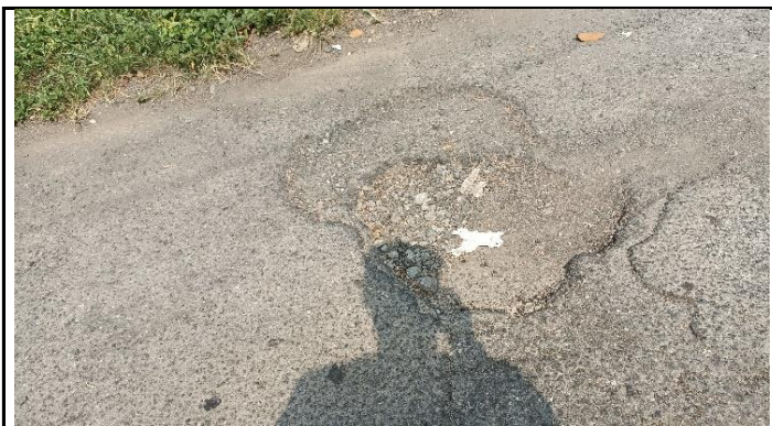
LAPISAN PERMUKAAN LANTAI BERLUBANG
