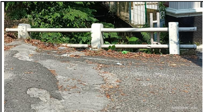
KONDISI SANDARAN JEMBATAN
