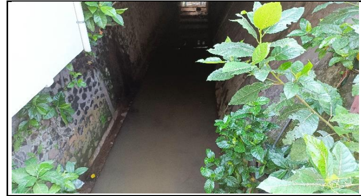
KONDISI BANGUNAN BAWAH
