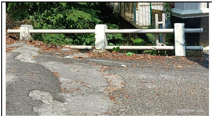
KONDISI SANDARAN JEMBATAN
