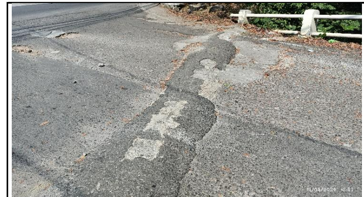
LAPISAN PERMUKAAN LANTAI BERLUBANG
