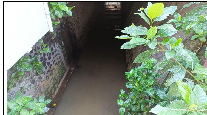
KONDISI BANGUNAN BAWAH
