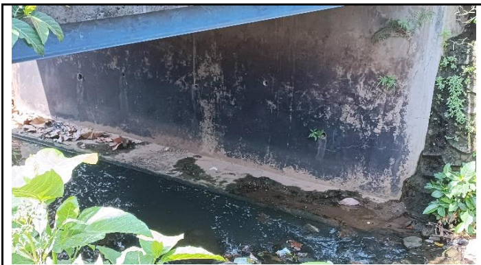
KONDISI BANGUNAN BAWAH
