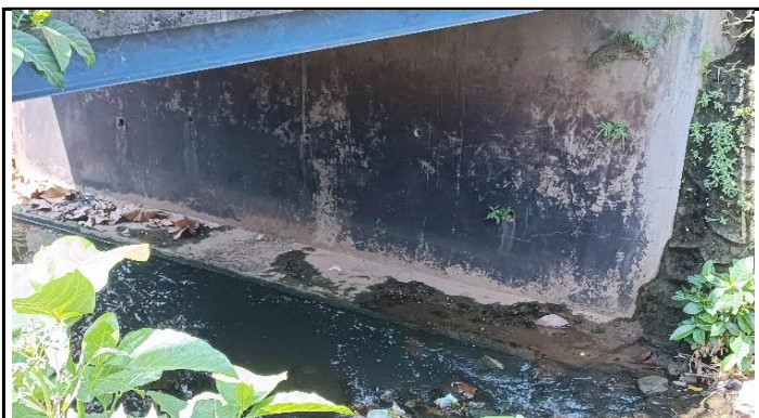
KONDISI BANGUNAN BAWAH
