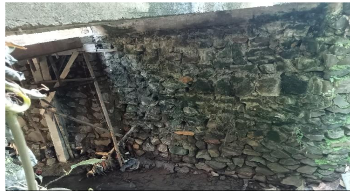
KONDISI BANGUNAN BAWAH
