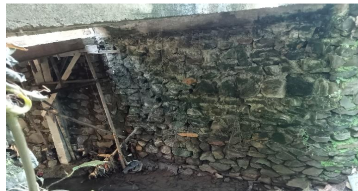
KONDISI BANGUNAN BAWAH
