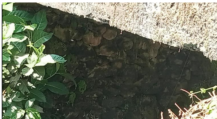
KONDISI BANGUNAN BAWAH
