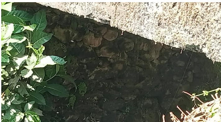
KONDISI BANGUNAN BAWAH
