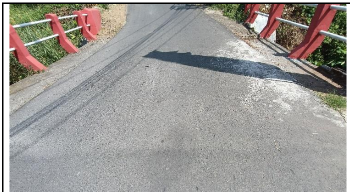
KONDISI LAPISAN PERMUKAAN LANTAI
