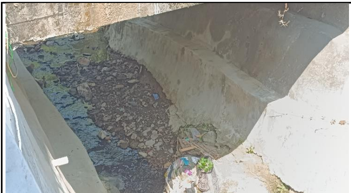
KONDISI BANGUNAN BAWAH
