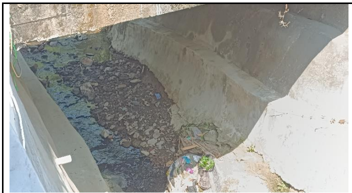
KONDISI BANGUNAN BAWAH
