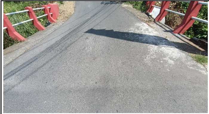
KONDISI LAPISAN PERMUKAAN LANTAI
