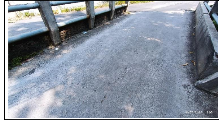
KONDISI LAPISAN PERMUKAAN LANTAI
