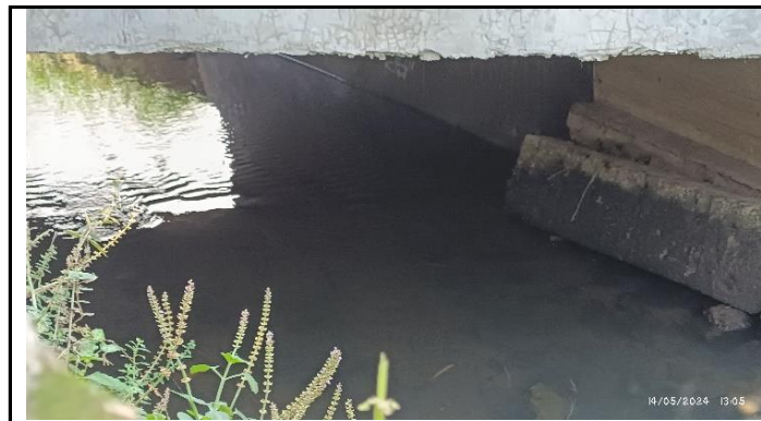
KONDISI BANGUNAN BAWAH
