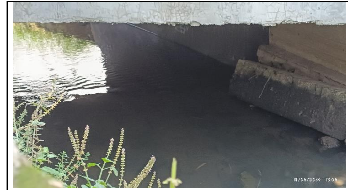
KONDISI BANGUNAN BAWAH
