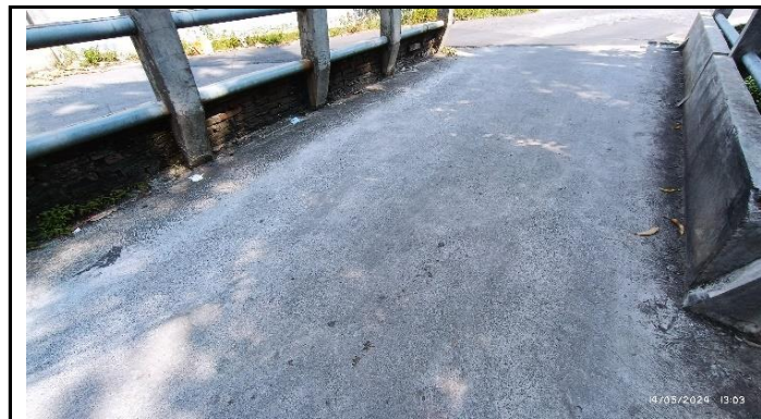
KONDISI LAPISAN PERMUKAAN LANTAI
