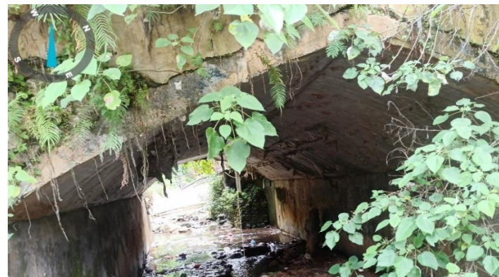
KONDISI BANGUNAN BAWAH
