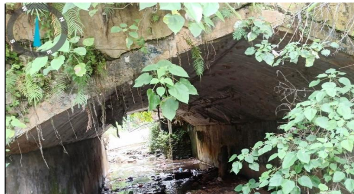
KONDISI BANGUNAN BAWAH
